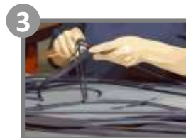
Desbarbado de la junta
